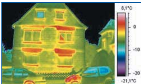
„Ciepłe punkty“ w miejscu złej izolacji
