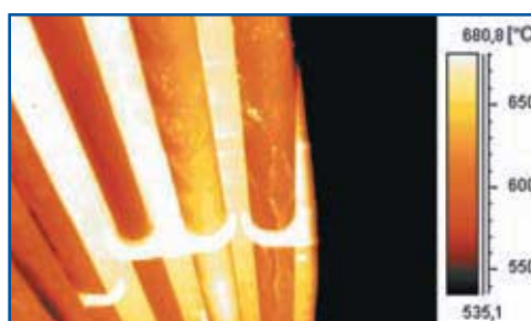
Uszkodzenia orurowania kotła poprzez odkładanie się koksu
